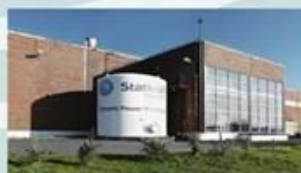
挪威Statkraft 渗透能发电站
